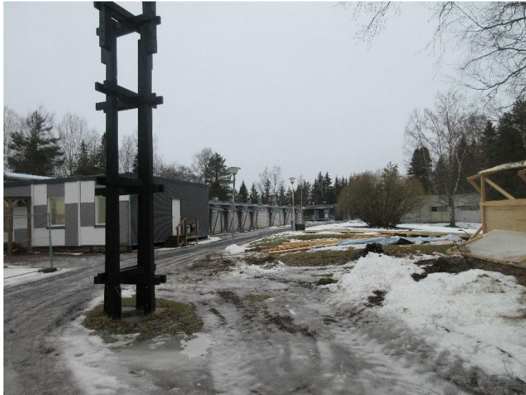
Sairilan päärakennuksen remontointi, kävelytie toimisto- ja ruokailuparakeille
