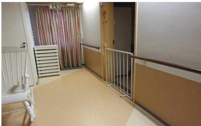
Kuva 1: Portti asukashuoneen ovella sekä huonekalu varaueloskäynnin edessä.
