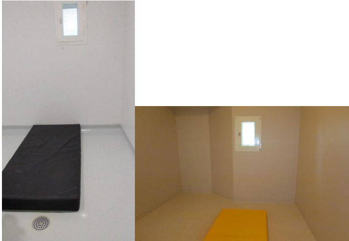
Osastojen 5 ja 8 eristystilat
