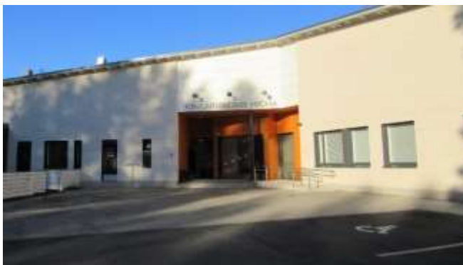
Kuva 1. Esteetön sisäänkäynti kuntoutuskeskukseen
