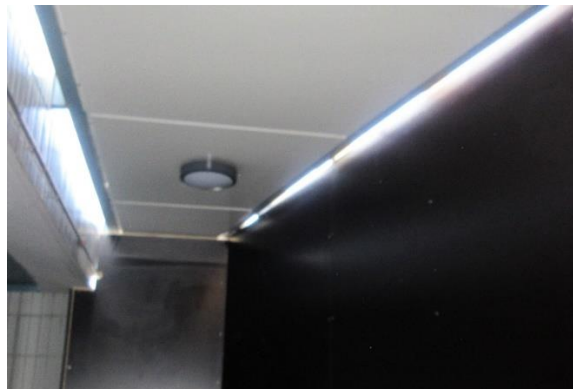
Ulkoilutilan katonraja, jossa pieni rako ulkoilmaan
