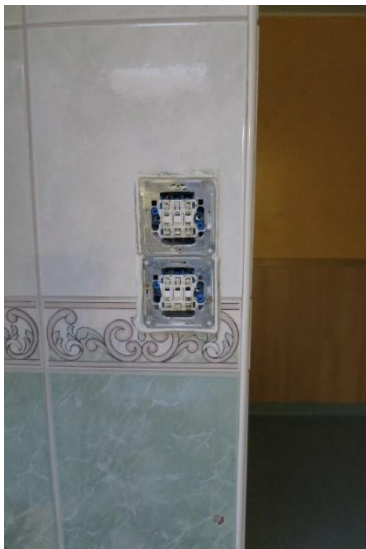
Kuva 5. Sähkökatkaisimen suojien puuttuminen
