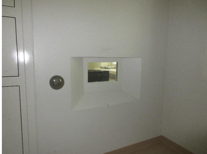
Nuoriso-osaston eristyshuoneen valvontaikkuna
