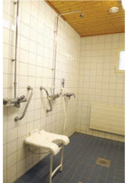
Yhteisessä suihkuhuoneessa oleva suihku-istuin.
