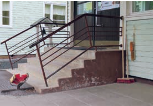
Äänestyspaikalle johtava portaikko.
