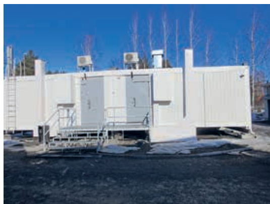
Poliisilaitoksen väliaikaisessa moduulivankilassa sellitilat on muodostettu konteista.
