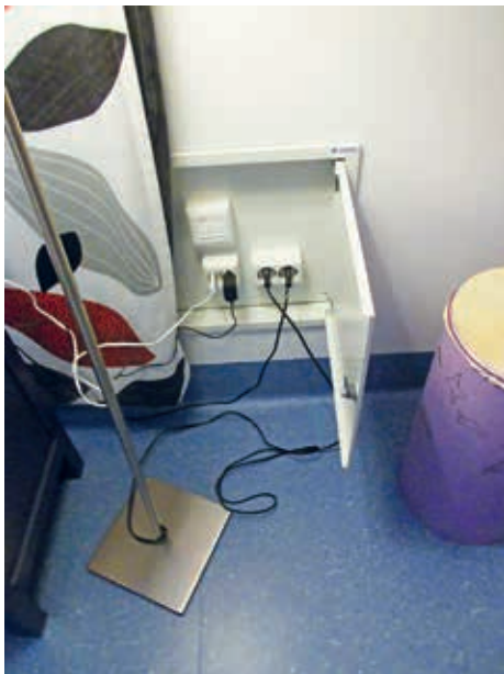
Asumisyksikkö Tempossa asukkaiden huoneissa pistorasiat voidaan yksilöllisen arvion mukaan pitää esillä tai lukollisen oven takana.
