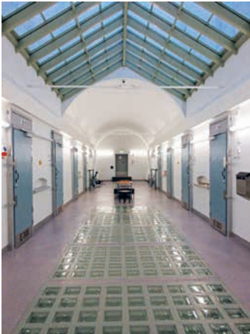
Helsingin vankilan remontoitu sellikäytävä.
