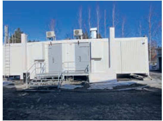
Cellerna i polisinsrättningens tillfälliga modulfängelse är inhysta i containrar.
